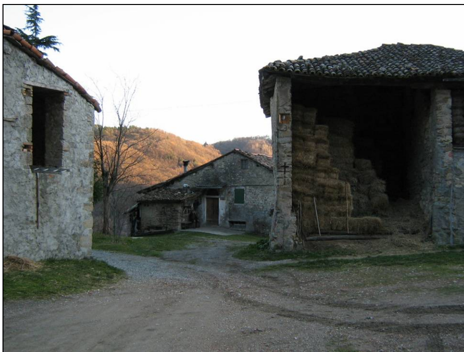
Figura 12 - Borzano (Loiano). Gli edifici medievali che compongono il piccolo nucleo rurale.
