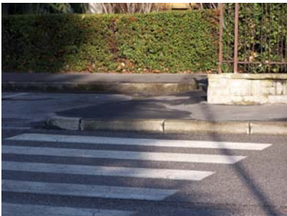
Foto 1: Barriera architettonica per mancanza di scivolo;
