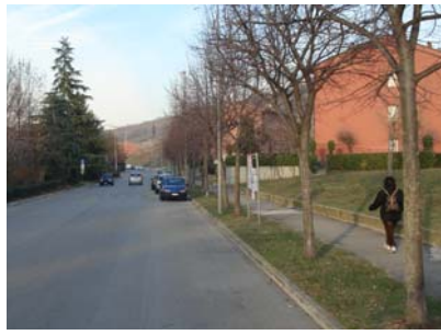
Foto 2: Via dello Sport, assenza di segnaletica orizzontale, ma percorso pedonale protetto;
